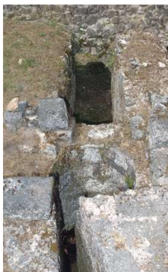
Bief - Meule - Ouvrages hydrauliques (Fotopol - SIGM)
